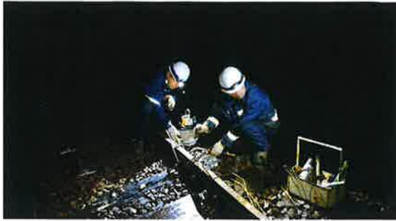
【レールボンド設置訓練】
