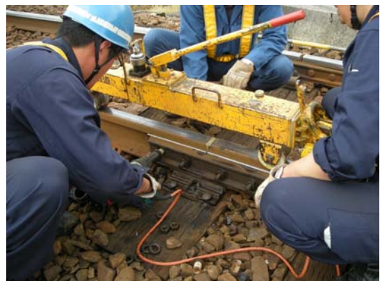
レール遊間調整訓練
